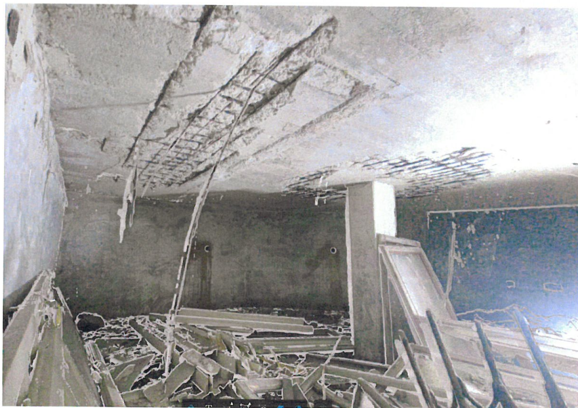
Foto nr. 4 – Placă beton armat cu acoperirea expulzată și armătura corodată
