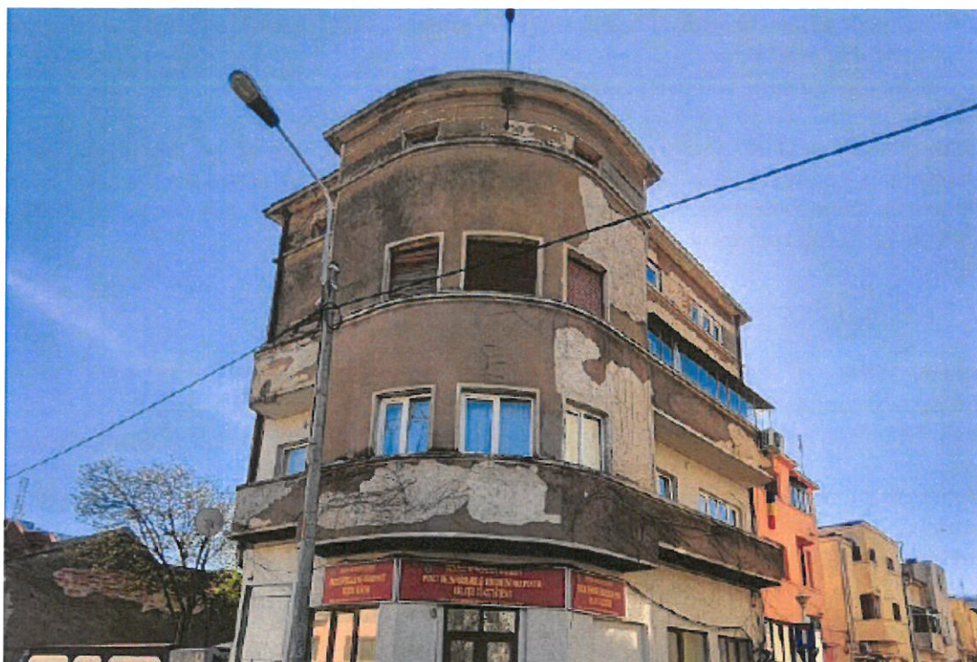
Figura 13 – Tencuială căzută pe suprafețe mari
