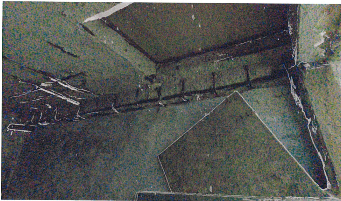
Foto nr. 3 – Grindă beton armat cu acoperirea expulzată și armătura corodată
