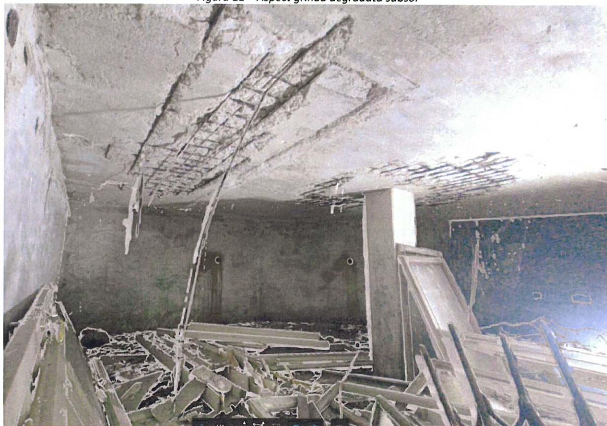
Figura 12 – Degradări extinse ale planșeului peste subsol
