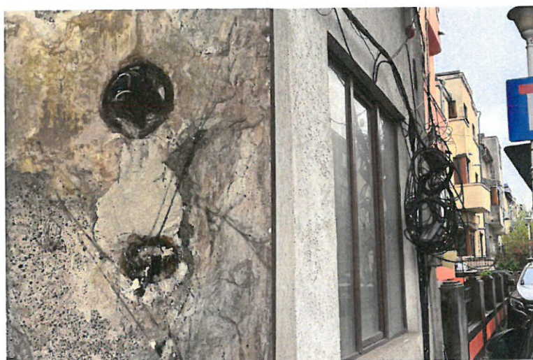
Foto nr. 14 – Legături neizolate, instalații CATV pe fațadă
