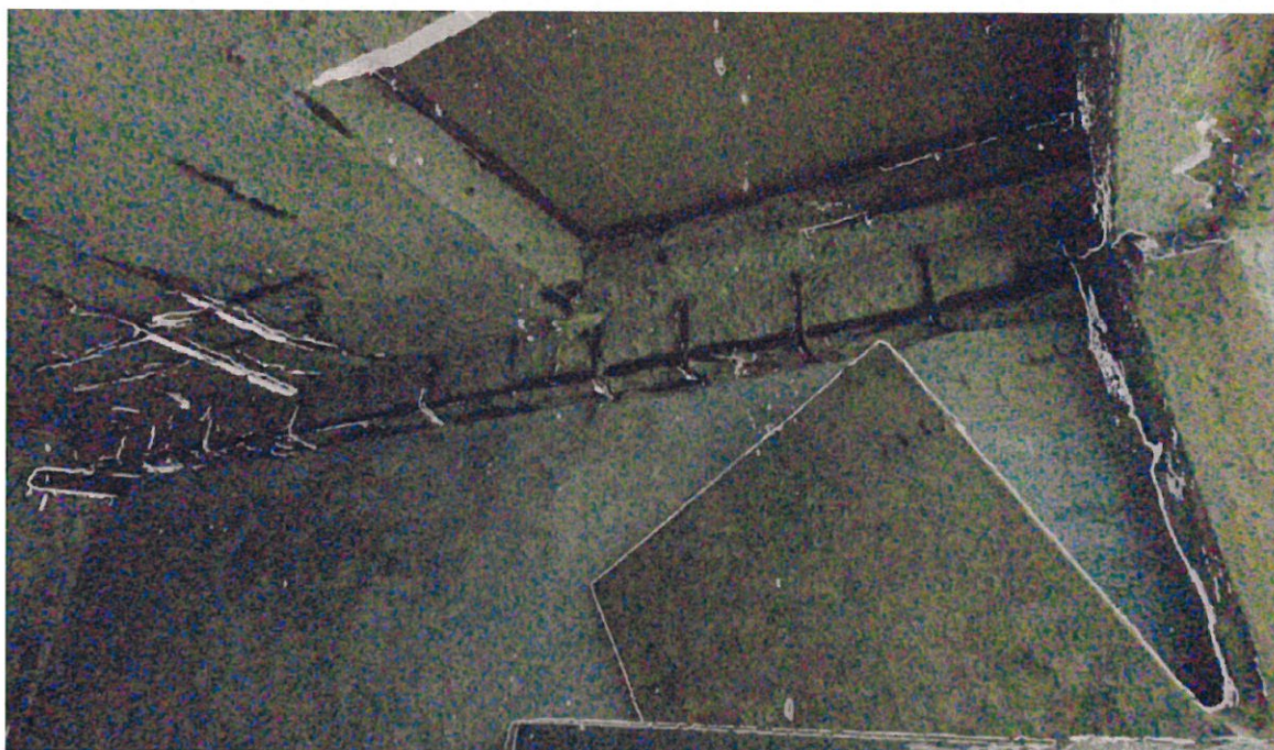
Figura 11 – Aspect grindă degradată subsol
