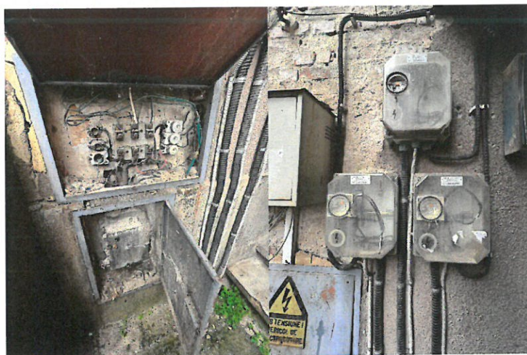
Foto nr. 13 – Firidă principală/ BMP-uri în exterior
